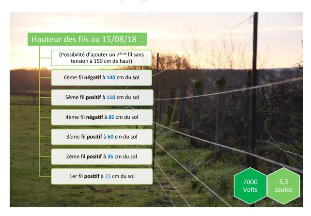
Les fils positif et négatifs sont alternés (partie haute de la clôture) pour infliger une expérience négative même en cas de saut d'un prédateur entre deux fils de la clôture (contact entre un fil positif et négatif).
